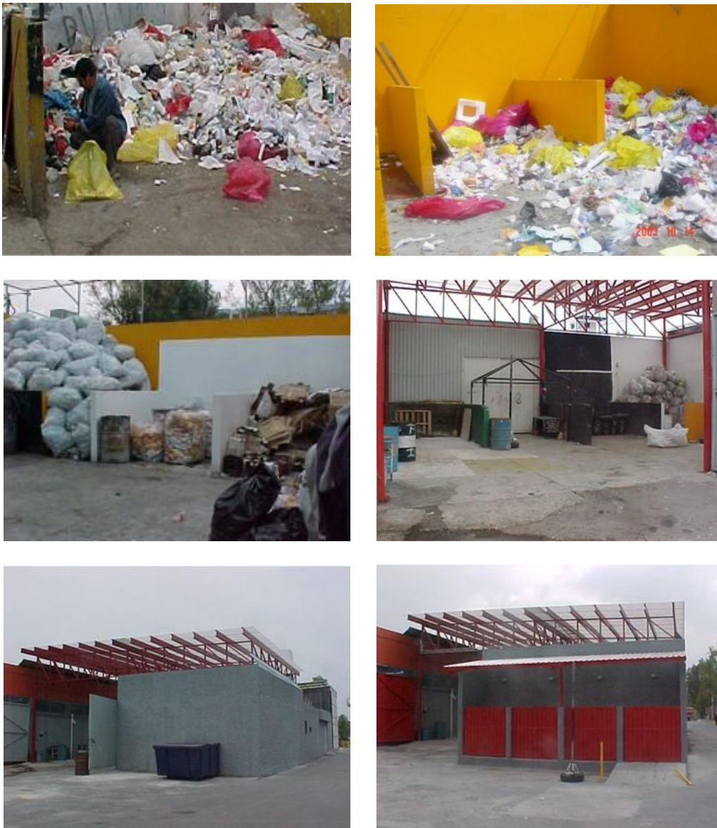
Figura 22. Centro de acopio
